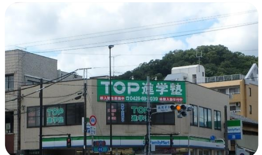
写真 屋外広告物撤去後
