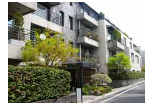
住棟を分節化し、外観に表情を持たせた例 ( 文京区 )
