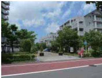
多摩ニュータウンの中高層住宅団地
