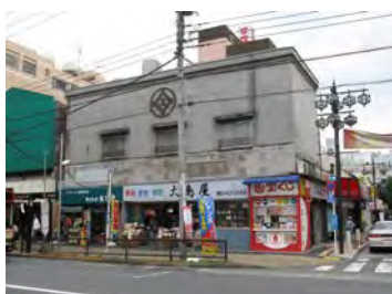
甲州街道沿いに立地する看板建築
