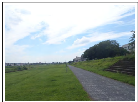
■緑化された護岸（浅川 市役所北側）
