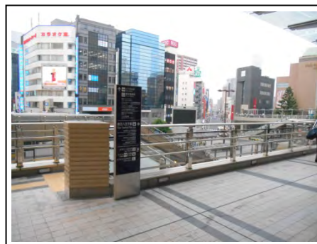
■ペデストリアンデッキのステンレス製防護柵に調和した金属製の案内サイン（JR八王子駅北口）
