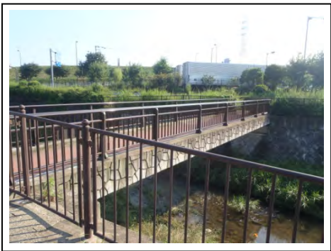
■ 景観推奨色を用いた防護柵としている (谷地川 日向橋)
