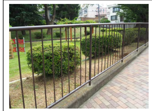
■視界が通る透過性のフェンスを設ける（六本杉公園）
