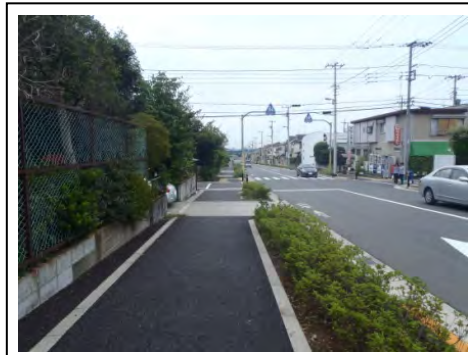
■新規に供用開始した都市計画道路では電柱を片側に寄せている（散田町）
