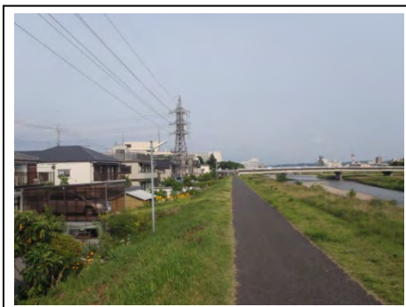
■緑化された堤防と管理用通路（歩行者専用）を設けた河川（浅川 暁橋左岸下流）
