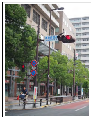
■信号柱に標識を共架し、構造物の林立しないよう工夫している （甲州街道 八日町）
