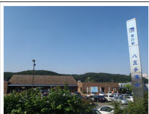
■丘陵地の緑を引き立てるような外壁色と屋根色を用いた建築物（道の駅 八王子滝山）
