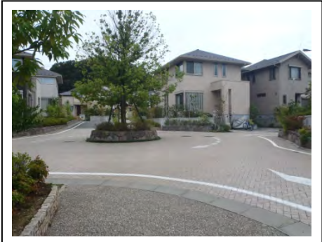
■交差点部を暖色系のインターロッキング舗装にし、周辺住宅街の景観に配慮しつつ緩やかな注意喚起を促している （七国）
