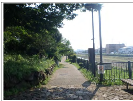
■アスファルトと調和した水辺のインターロッキング舗装としている (大栗川 番場橋周辺)
