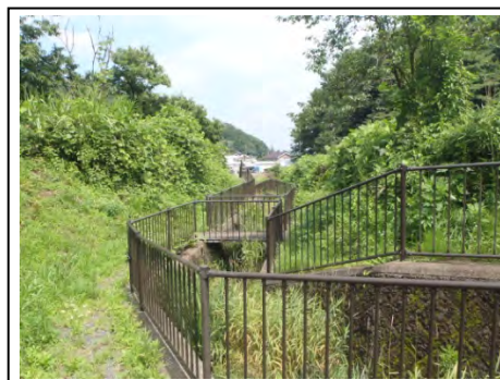
■シンプルな形態・意匠とし、ブラウン色で統一された防護柵としている (上柚木の水路)
