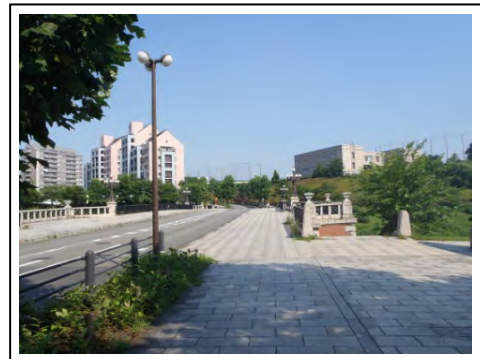
■道路・橋梁と舗装の素材や色彩を合わせ連続性に配慮させている (長池見附橋 別所)
