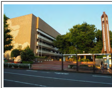
■前面道路との間にゆとりを持った配置としている（八王子市役所）
