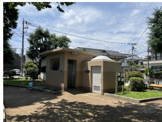
子安公園トイレ (子安町4-21 子安公園内)
