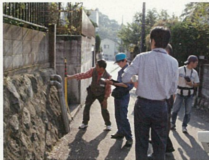
擁壁班のまち点検
