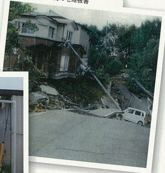
平成16年中越地震の宅地被害
