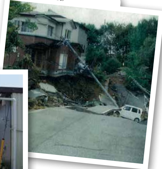
宅地被害（中越地震）
