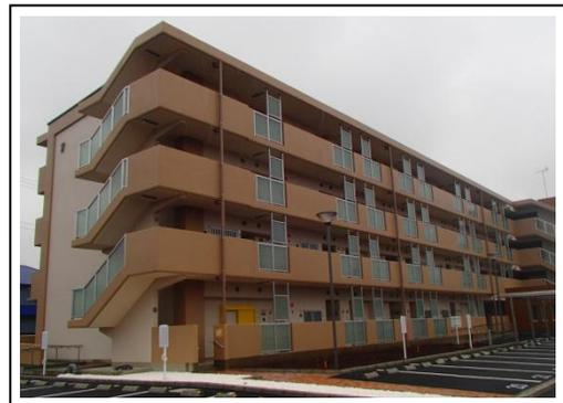
■ 長大な壁面に対し、壁面の凹凸や色彩によって圧迫感の軽減を図っている
