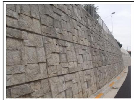
■擁壁面を化粧仕上げとして、圧迫感を軽減させている（散田町）
