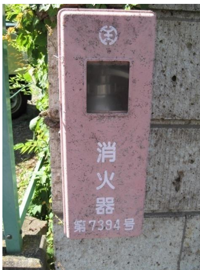
《街頭消火器の外観》
