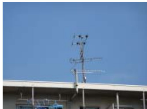
【大和田台団地共同アンテナ改修】
