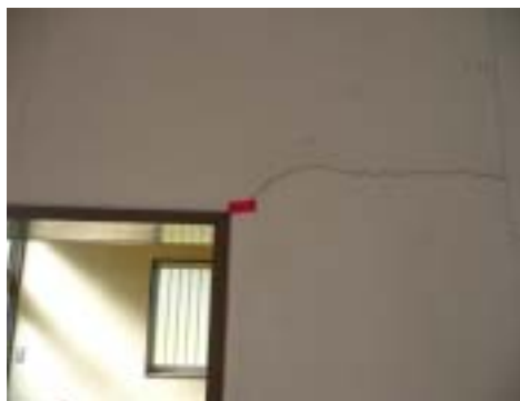
【大和田台団地集会所内部】
