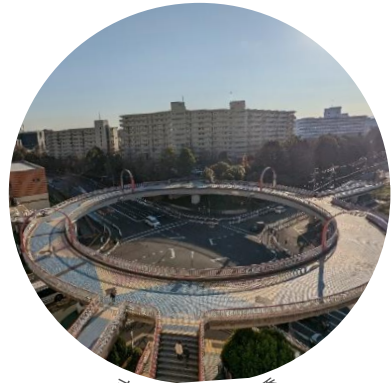
南大沢輪舞歩道橋
