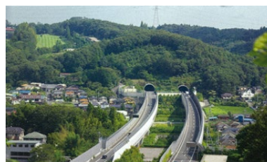
▲圏央道 川口トンネル
