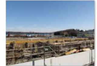
35.ホームック建設工事.jpg
