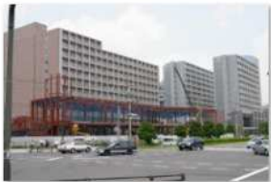
31.フレスポ建設中.jpg
