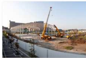
33.みなみ野館解体.jpg
