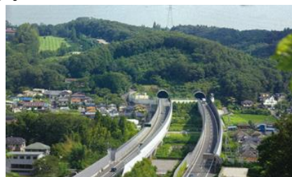
▲圏央道 川口トンネル
