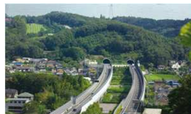
圏央道 川口トンネル
