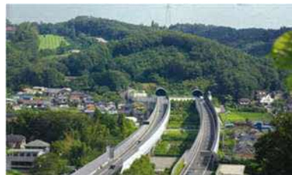
▲圏央道 川口トンネル
