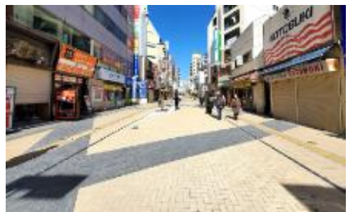
写真2 景観舗装後のユーロード(中町)
