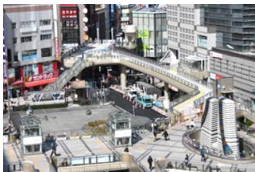
写真1 延伸後のマルベリーブリッジ
