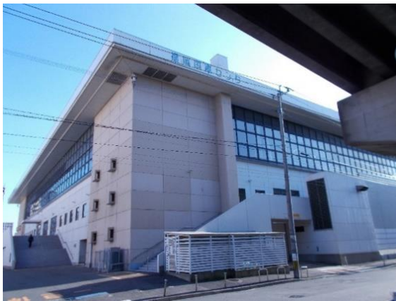
写真3 福岡国際センター外観
