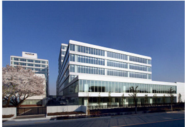
平成 20 年度指定 オリンパス㈱ (市内拡張の例・石川町)
