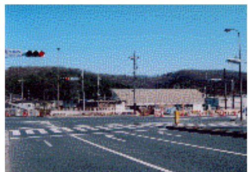
写真８ 工事中の道の駅「八王子滝山」
