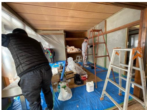
空き家改修の様子
