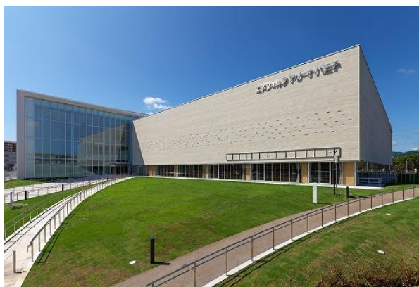
エスフォルタアリーナ八王子の外観
