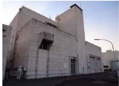
八王子市北野下水処理場の老朽化した施設
