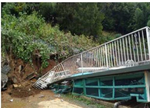
▲加住小学校での土砂崩れ (平成 29 年台風第 21 号)
