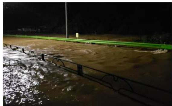
▲上恩方町の陣馬街道 (令和元年東日本台風)
