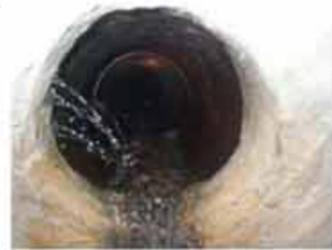
老朽化により下水道管内に侵入水が流入しています。
