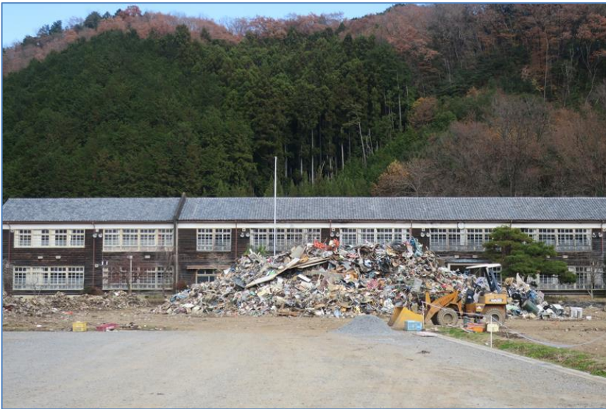
令和元年(2019年) 12月12日 災害廃棄物置き場状況
