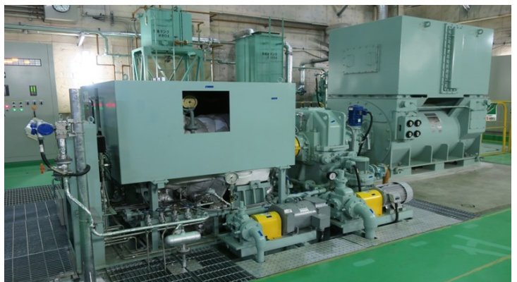
更新後の蒸気タービン発電
