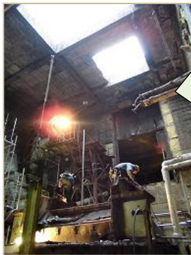
開口した屋根と機械の撤去状況
