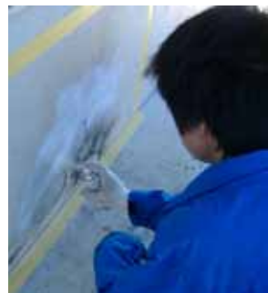
トイレ外壁の焼け焦げ跡をスプレーで修復
