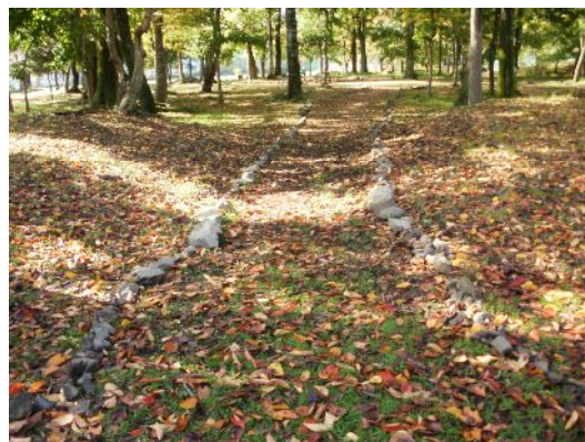
石を並べて遊歩道を整備しました
