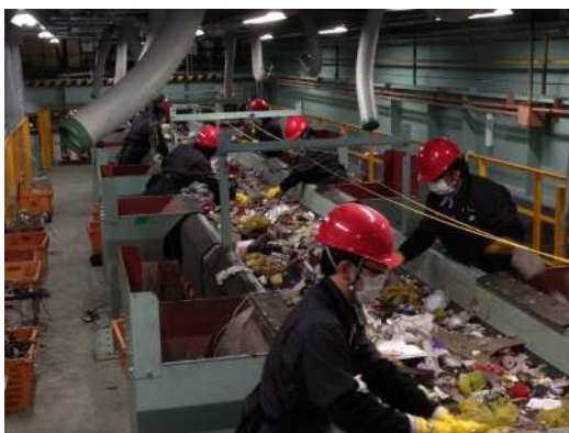
不燃物処理センター
