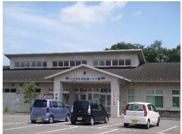
余熱利用施設「戸吹湯ったり館」
