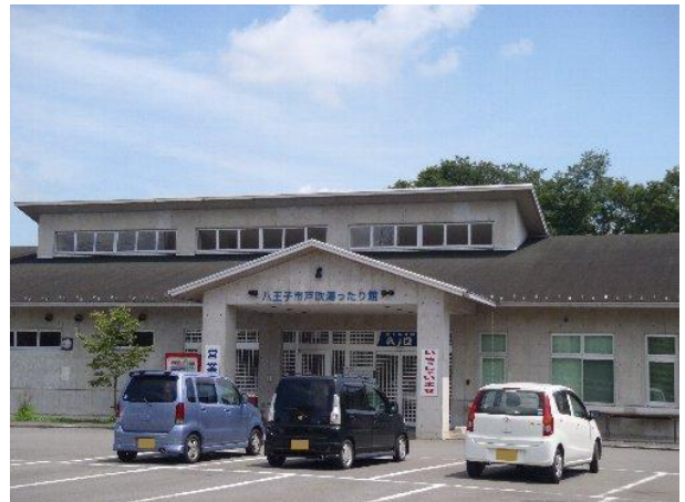
余熱利用施設「戸吹湯ったり館」
