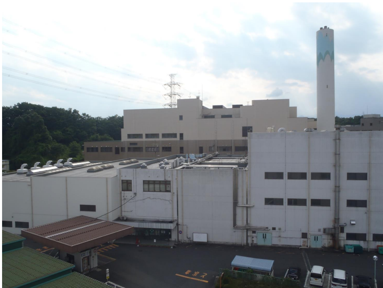
不燃物処理センター
