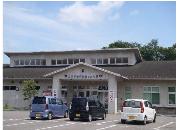
余熱利用施設「戸吹湯ったり館」
