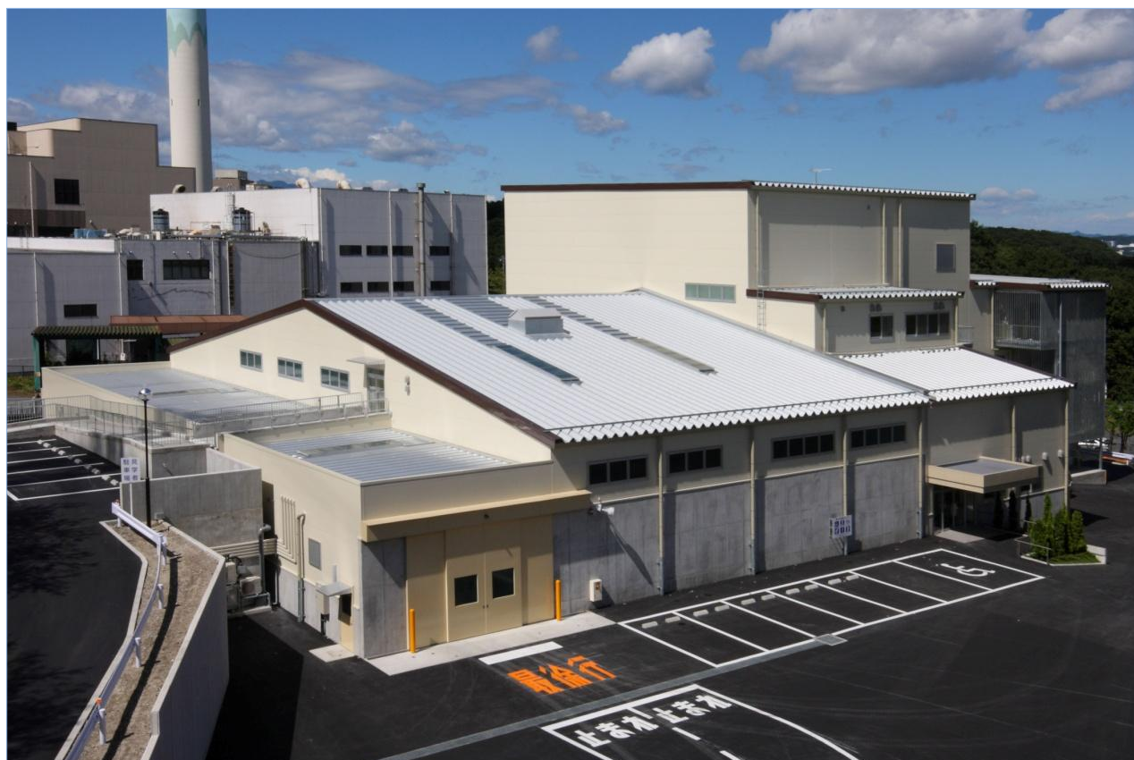
プラスチック資源化センター
