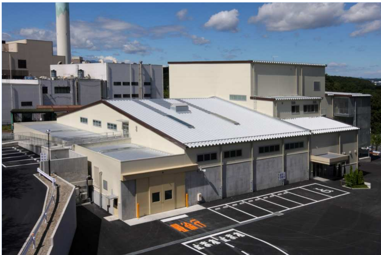
プラスチック資源化センター
