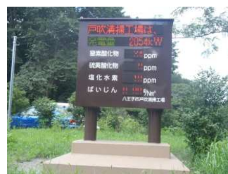
排ガス状況表示盤
