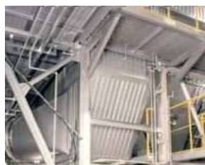
脱硝反応塔
