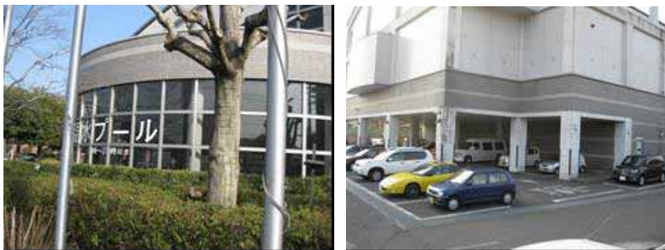
図表 1-80 施設写真(プール外観と駐車スペース)
