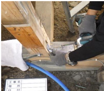
▲耐震金物取付
