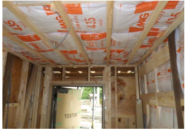
▲ 壁・天井の断熱改修
