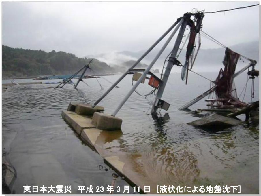
東日本大震災 平成 23 年 3 月 11 日 [液状化による地盤沈下]
