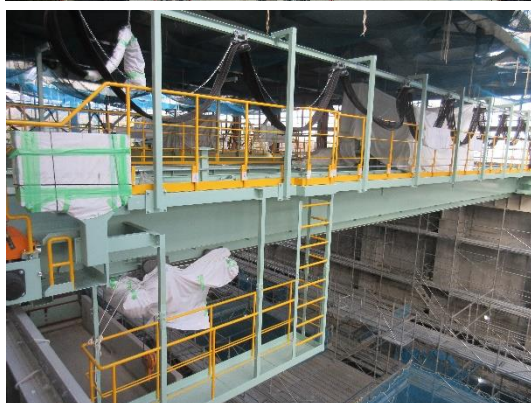
ごみクレーン据付状況
