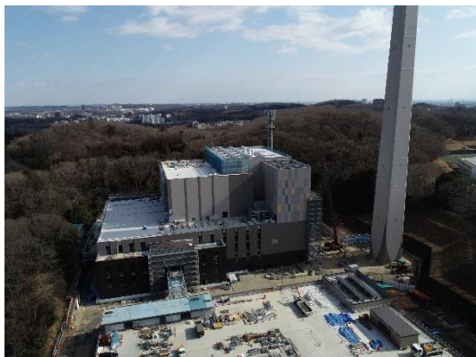
工事現場全景
