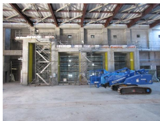
プラットフォーム施工状況
