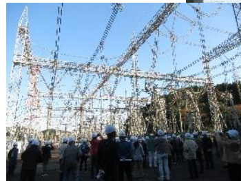
(変電所視察研修)
