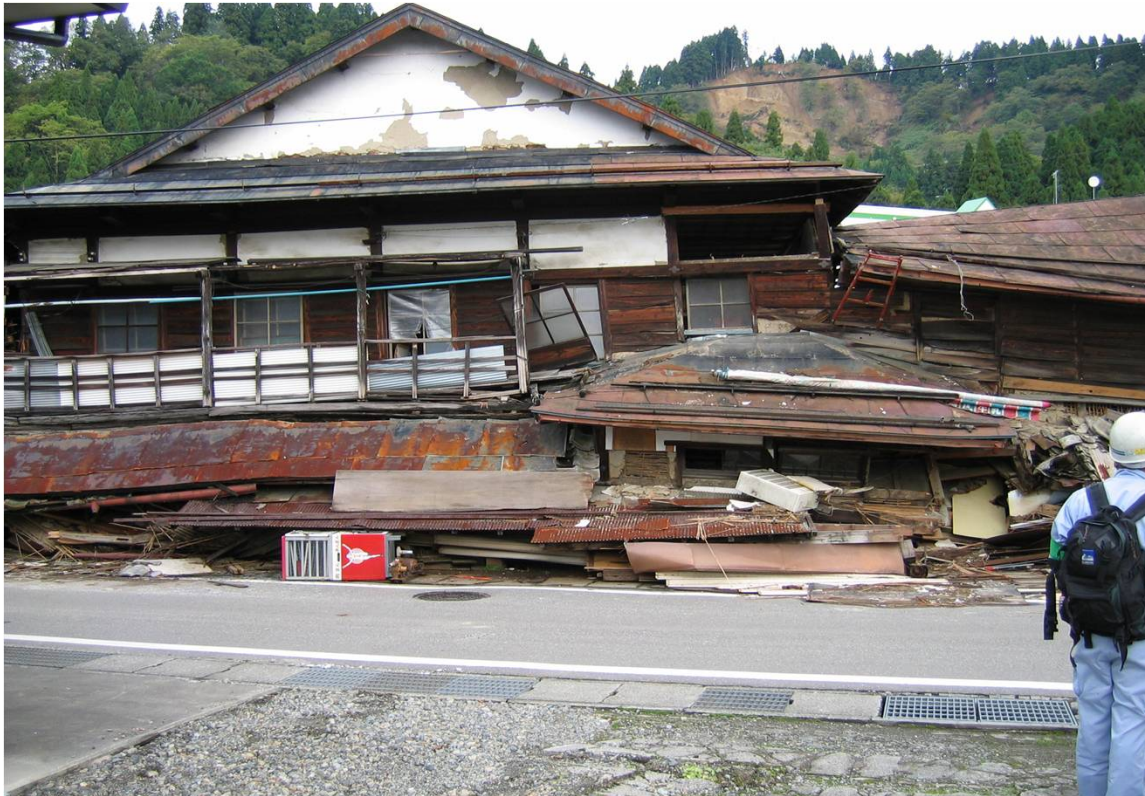
▲倒壊の木制房屋(阪神淡路大地震时的景象) ▲倒壊した木造住宅(阪神・淡路大地震で)
