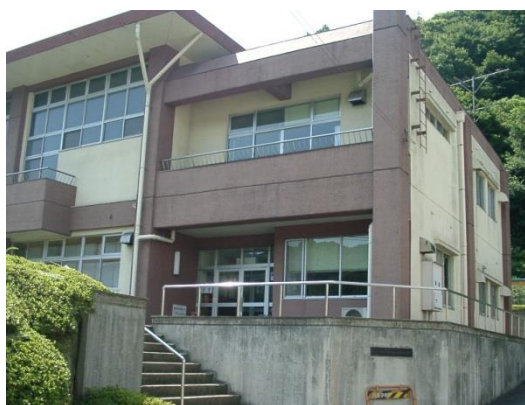
恩方農村環境改善センター
