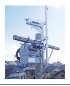
高圧受電設備のための引込柱に設置する高圧気中開閉装置(P.A.S)の新設や取替工事ができる工具。高所作業車の入れない様な狭い場所でも短時間かつ安全に P.A.S の取付取替作業ができる。
