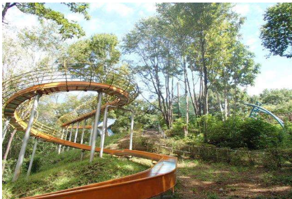
殿入中央公園のローラー滑り台
