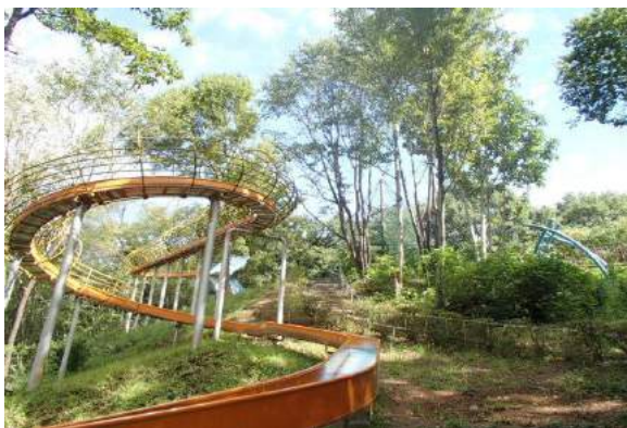
殿入中央公園のローラー滑り台
