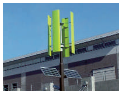
あったかホールの風力と太陽光 のハイブリッド発電装置 (平成 21 年度設置、0.28kW)
