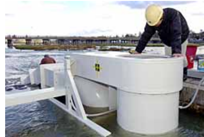
渡月橋のやや上流に設置された小水力発電施設 (京都新聞 HP より)
