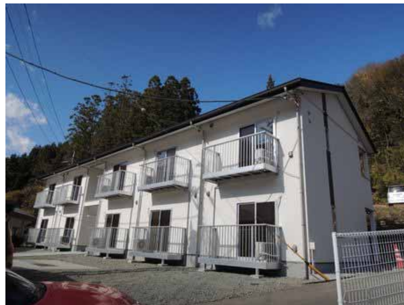
上野村・村営住宅
