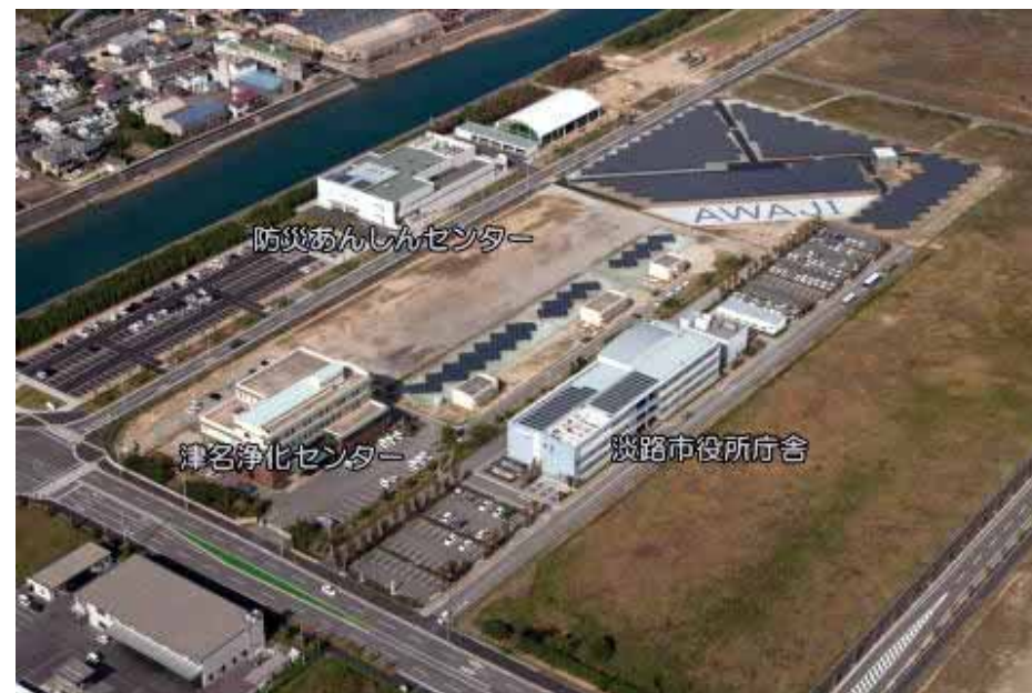
あわじメガソーラー 1 全景 (淡路市 HP より)
