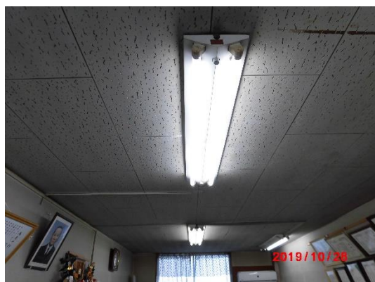
改修前 事務所
