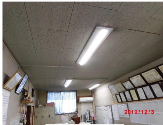
改修後 事務所
